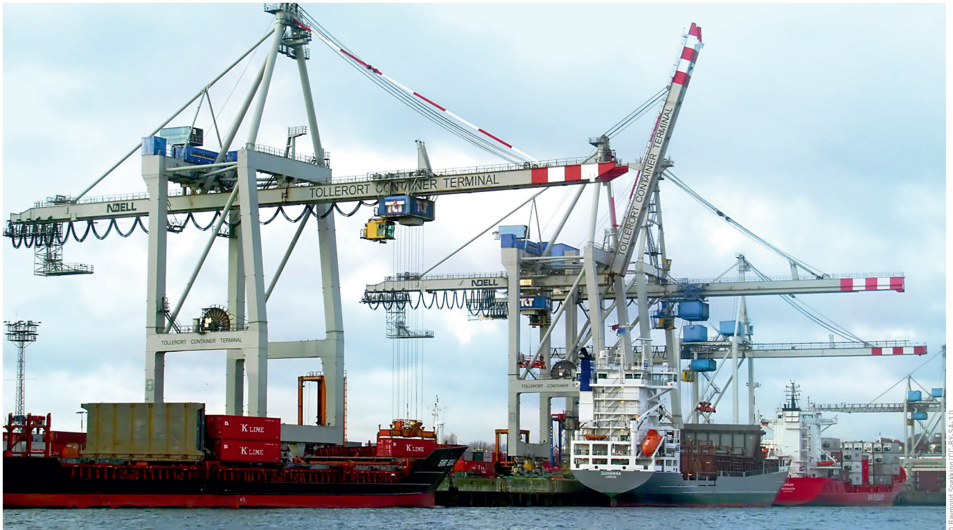
Containerterminal Tollerort im Hamburger Hafen
